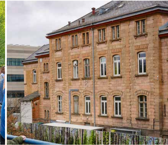
Das noch bestehende Gebäude der „Hupfla“
